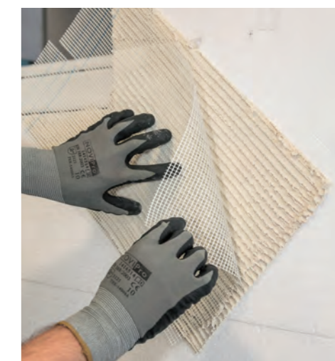
Réalisation d'un renfort d'angle en partie courante.
