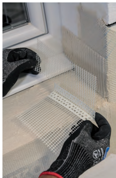
Réalisation d'un renfort appui-tableau.
